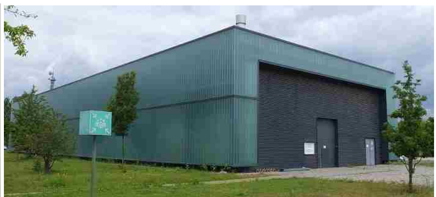
[図2] ベルリン本社内に設置された技術センター外観(撮影:日経BP 総研クリーンテック研究所)
